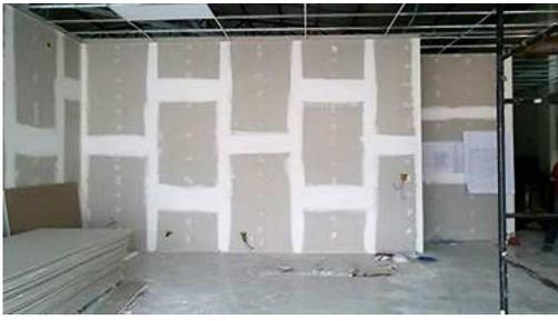
Foto ilustrativa da execução de emassamento e preparação de parede drywall para receber pintura.
